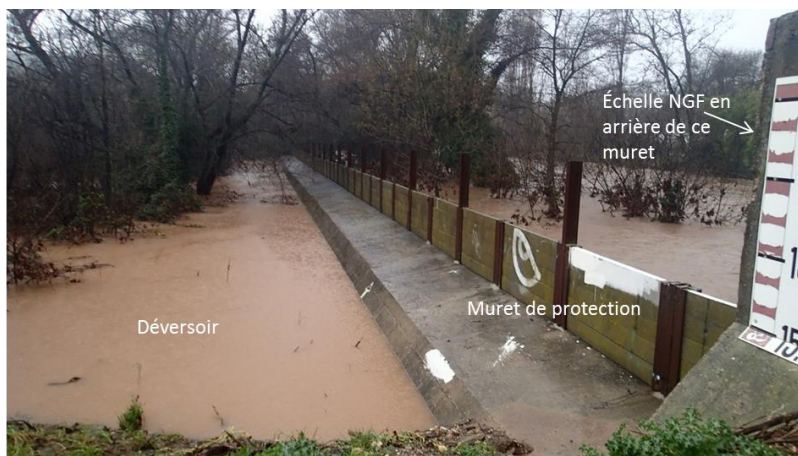
19 janvier 2014. Déversoir du Plan du Pont. Le Gapeau en crue.
