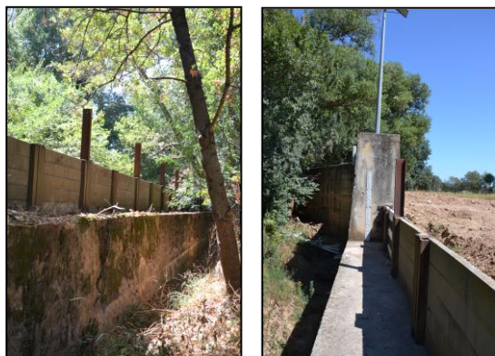
Photo 3 (gauche). Muret de protection, « déversoir » composé d'une partie ancienne bétonnée et d'un ajout de béton filtré. (année 2000) (26/08/15 ©E.G.)
