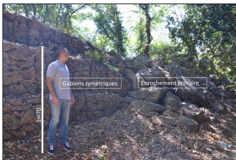
Photo 1 (dessus). Deux types d'enrochements qui ont servi pour dévier le tracé du cours d'eau du Gapeau au cours du XXème siècle. (26/08/15 ©E.G.)
