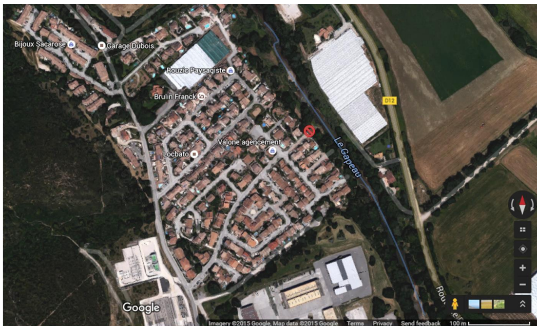
Arrêt 3. Quartier de l'Oratoire. Situé dans le « casier 2 », il est le premier ensemble résidentiel à être inondé lors des crues du Gapeau. Un clapet anti-retour a été installé à l'extrémité de l'allée des Ombres (symbole rouge) pour empêcher que les eaux du Gapeau en crue ne rentrent par le système des égouts.
