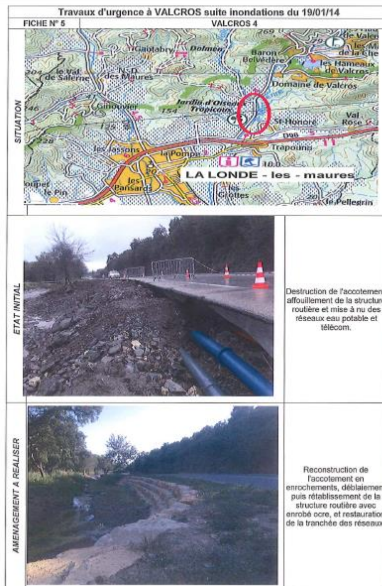
Figure 18. Fiche type de "travaux d'urgence" . Ici, reconstruction d'un accotement situé à Valcros (Source : Mairie de la Londe-les-Maures)
